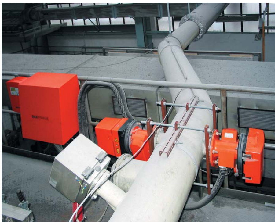
Mesure de l'ammoniac dans les installations de compostage et les usines d'incinération des déchets, également pour les applications dans les hôpitaux
