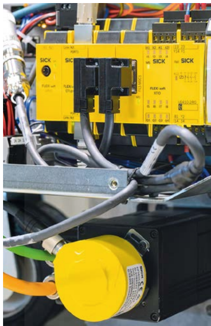
Un encoder de seguridad proporciona rápidamente los datos con los parámetros más importantes.
