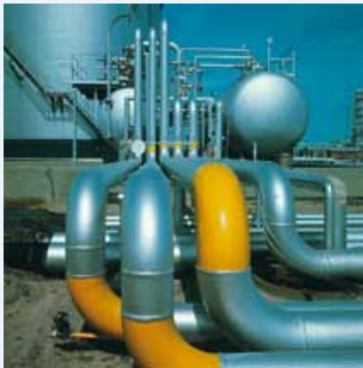
O 2 -Messung in der Gaserzeugung
